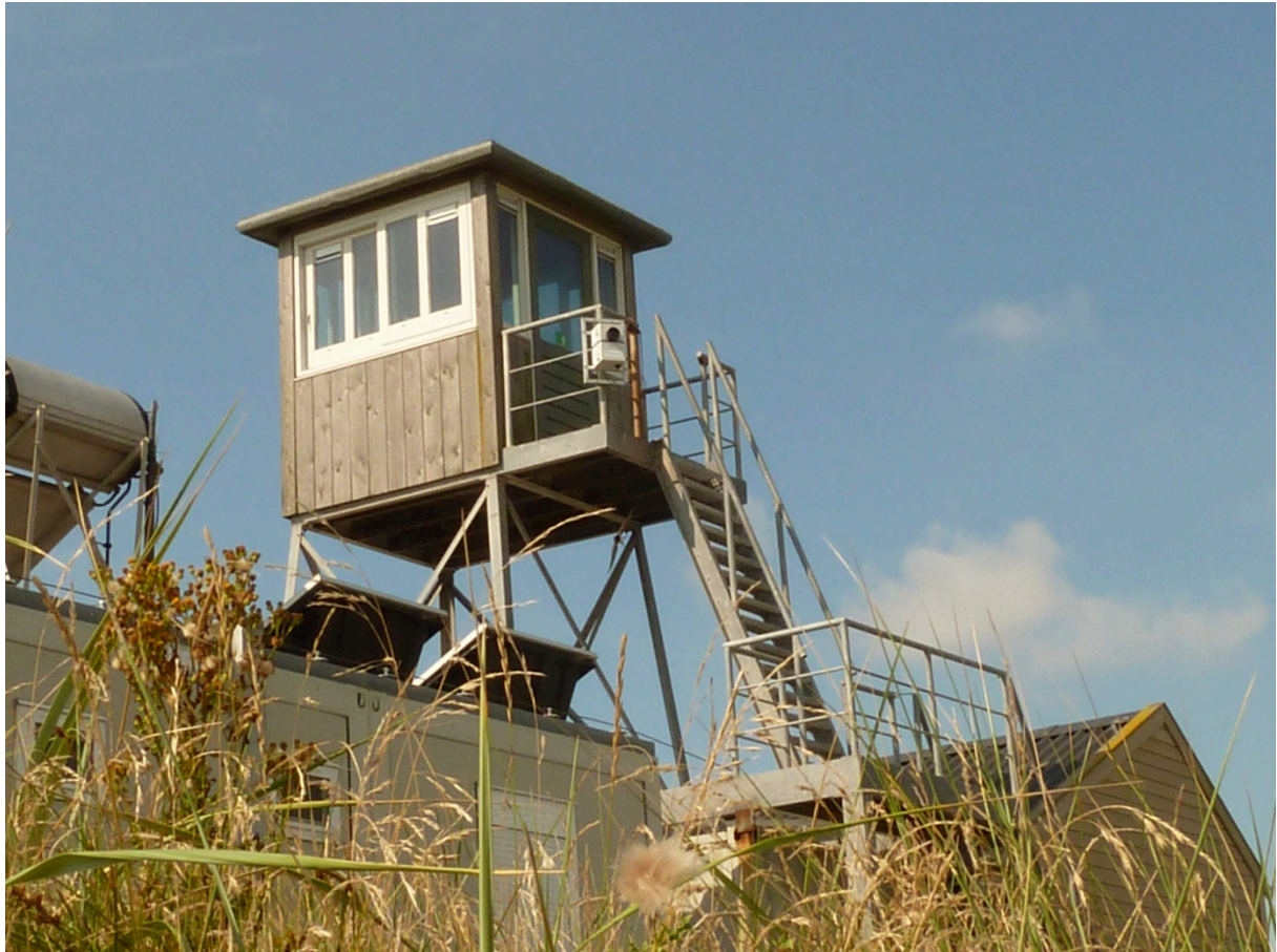
Figuur 2. De autorecorder geplaatst op de balustrade van de uitkijktoren van Rottumeroog
